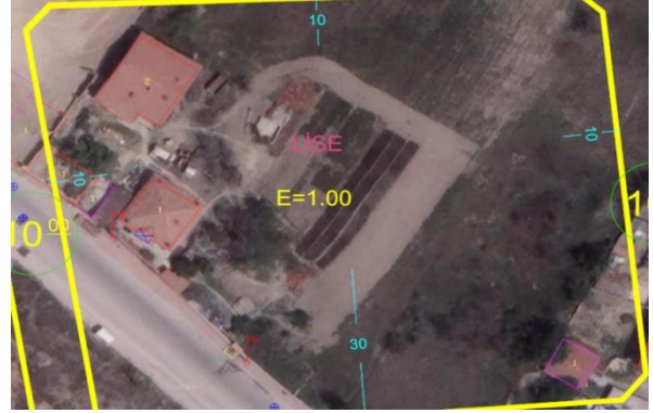
Şekil 7. Okul alanında bulunan imara aykırı yapılar.
