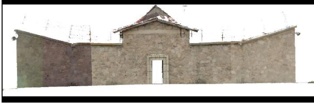
Şekil 7 – Sincan Cezaevi giriş kapısı tarafına ait ortofoto görüntü
