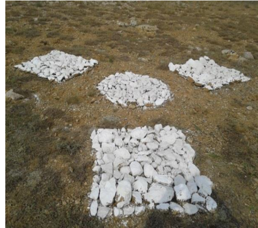
Şekil 5. YKN'nın kireçle taş döşenerek tesisi
