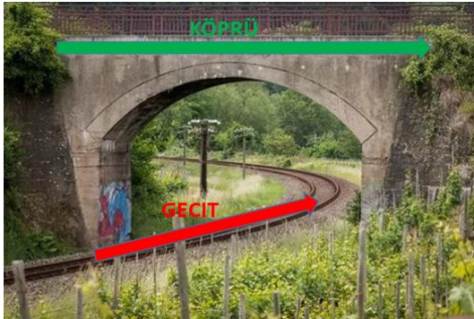
Şekil 23. Köprü ve Geçit Tanımı Örnekleri
