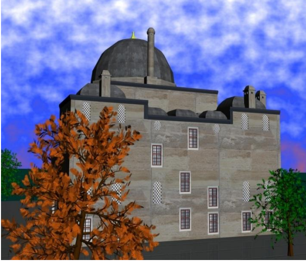
Şekil 8. Batı cephesi görüntüsü
