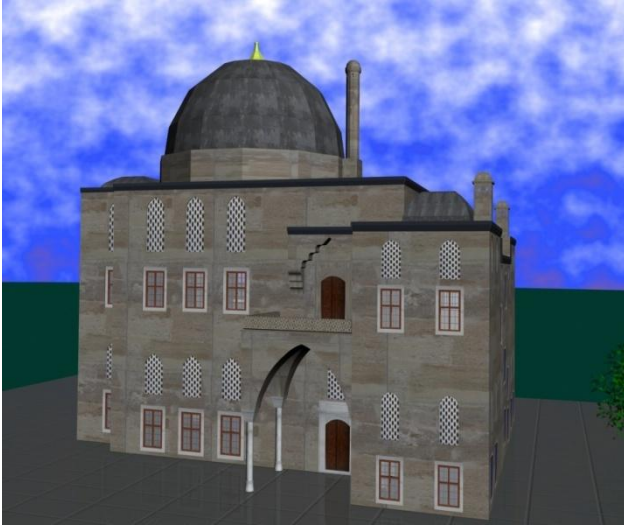
Şekil 9. Kuzey cephesinden bir görüntü
