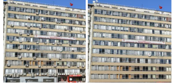
Şekil 10. Cephe dış ünitelerinin temizlenmesi
