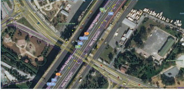
Şekil 8: D-100 Haliç köprüsü- Ayvansaray yönü trafik kazası noktaları.
