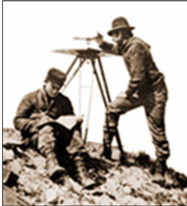
Şekil 1. Plançeteli alidat olometrik ile ölçme
