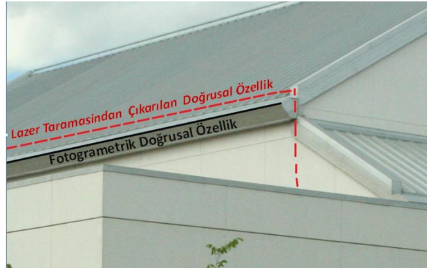
Şekil 4: Lazer taramasından çıkarılan doğrusal özelliğin fotogrametrik veride fiziksel karşılığının bulunmaması
