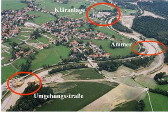
Şekil 2.2: Sel suları altında kalma tehlikesi altında kalan arıtma tesisi ve yıkılan köprü. Weilheim-Schongau'yu kapsar hava fotoğrafı, 24 ağustos 2005.
