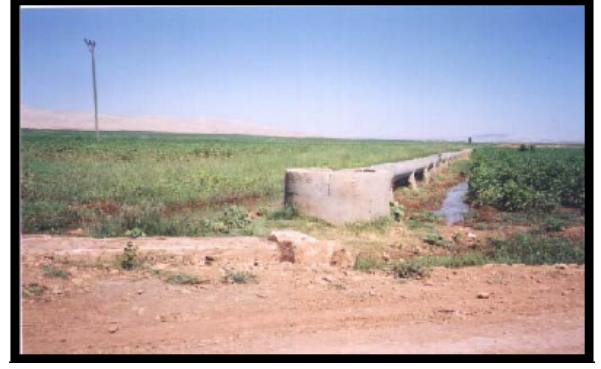
Şekil 3. Su sifonu detayı resmi
